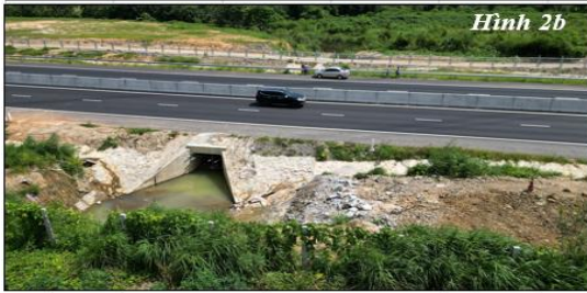
Thiết diện cống hộp không đủ đã gây ra ngập cao tốc. Ảnh Quê Hà
